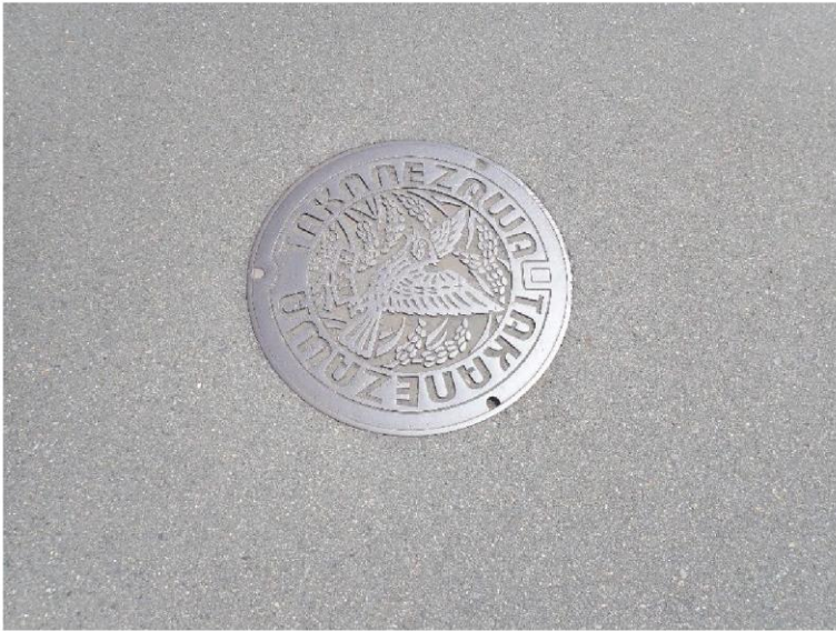
20 マンホール（汚水）
