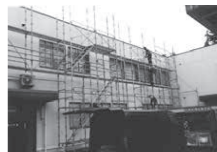
老朽化が見られる第3庁舎の工事風景
