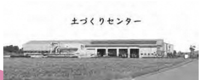
平成30年5月の倒壊以前の外観
