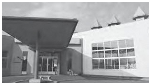
きのこのもりのホールにエアコンが設置されます
