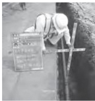
西町の水道工事の監理状況
