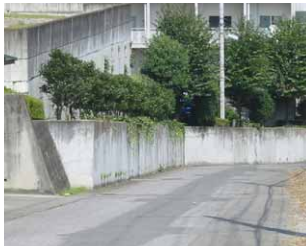
【段差・植栽により景観に配慮した擁壁】
